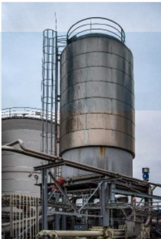
Scala a pioli fissa con gabbia di protezione
